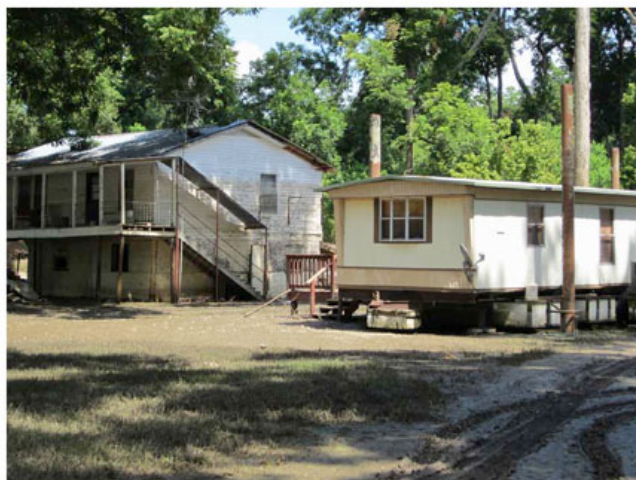
Une inondation en Louisiane en 2011 a submergé la maison traditionnelle à gauche presque jusqu'aux chevrons, comme l'indique la ligne des hautes eaux. Sa voisine, dotée d'une fondation flottante faite maison, est restée intacte. (Photo: Elizabeth English)
